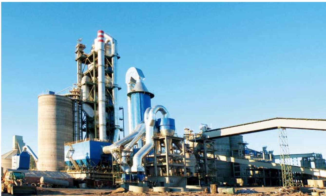
中国建材在哈萨克斯坦承建的新型干法水泥项目
