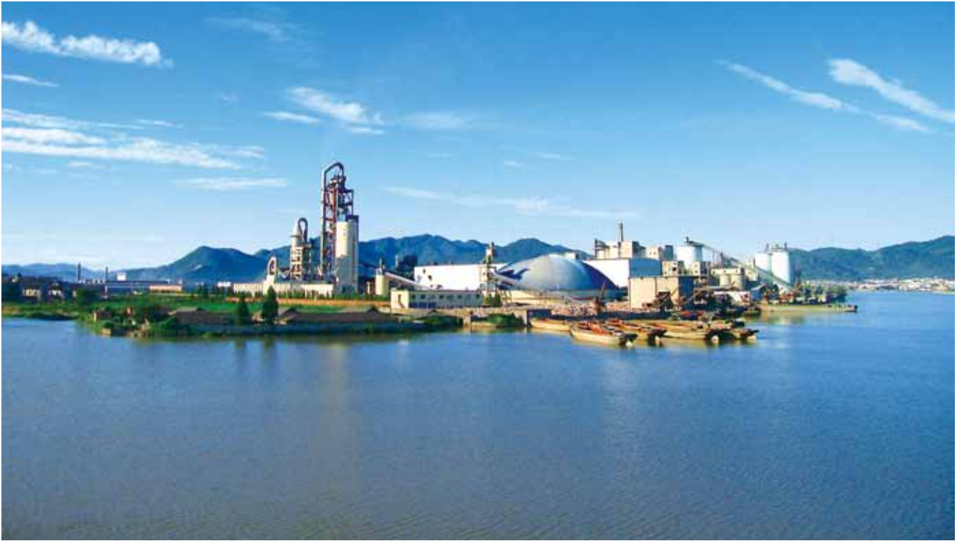
集团水泥企业污泥处理生产线，被誉为“水上明珠”
