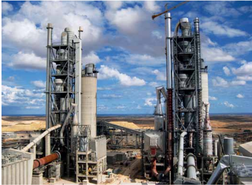
承包建设的海外项目
