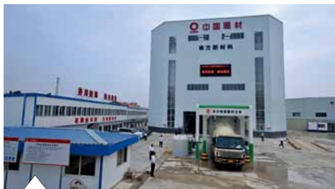
商品混凝土环保生产线
